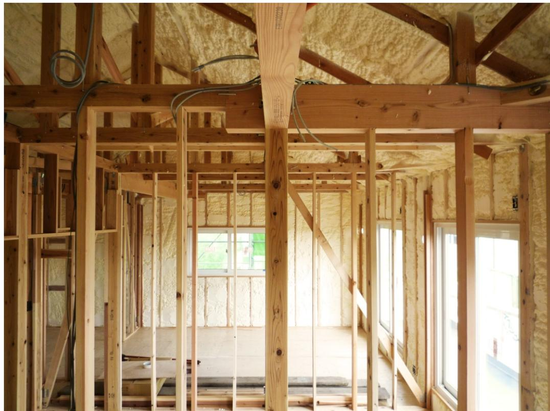
本現場の構造躯体内の写真です。壁や屋根までしっかりと隙間なく断熱材が吹き付けられています。これが住宅の省エネルギー化の一つの秘訣です。さらに、この断熱材は硬質ウレタンという非常に断熱性能が高いもの。発砲も水で行っているため環境にも優しい素材です。
